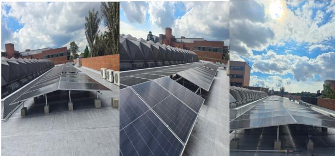
Imagen 2. Paneles instalados en sede central
