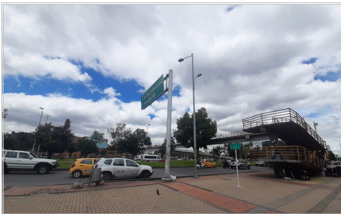
Figura 12. Exterior de la RNEC sobre la calle 26
