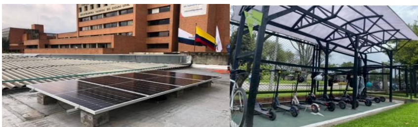
Figura 1. Eco estación de carga “Energía Verde”
